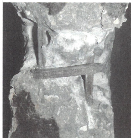
Obr.8 Vystuženie priečnika nosníka „Vloššák“ zospodu
