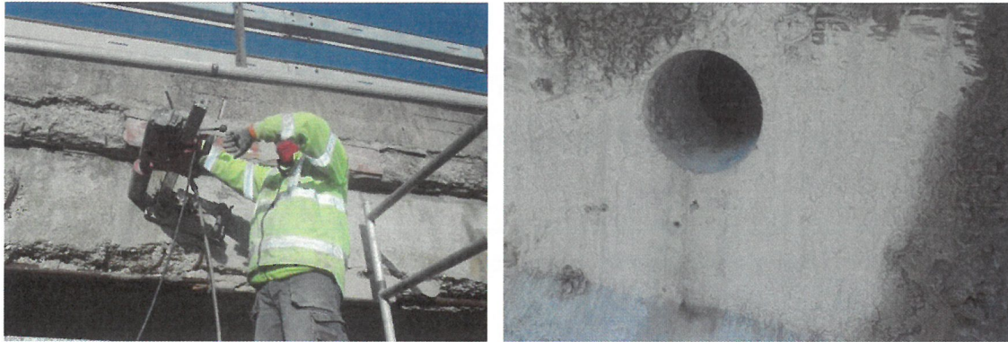
Obr. 1 Odber jadrového vývrtu
