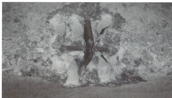
Obr.9 Vystuženie steny nosníka „Vloššák“
