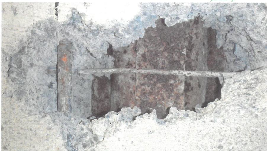
Obr. 16 Vystuženie nosnej konštrukcie
